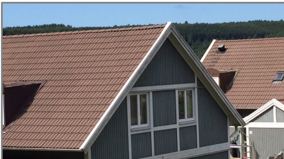
12 betongtak rengjordes och behandlades med Prebona DuraClean. Taken får ökad livslängd samt håller sig torra, rena fräscha under lång tid efter behandling med Prebona DuraClean.
